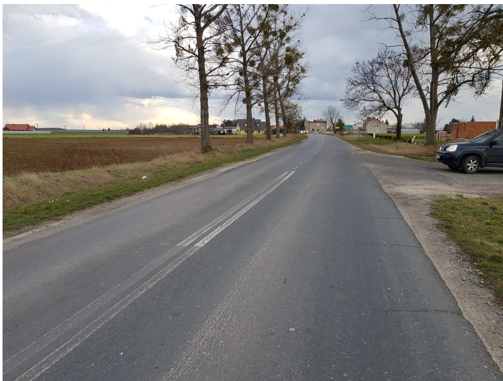
Fot. 4 Stan istniejący - km 3+550
