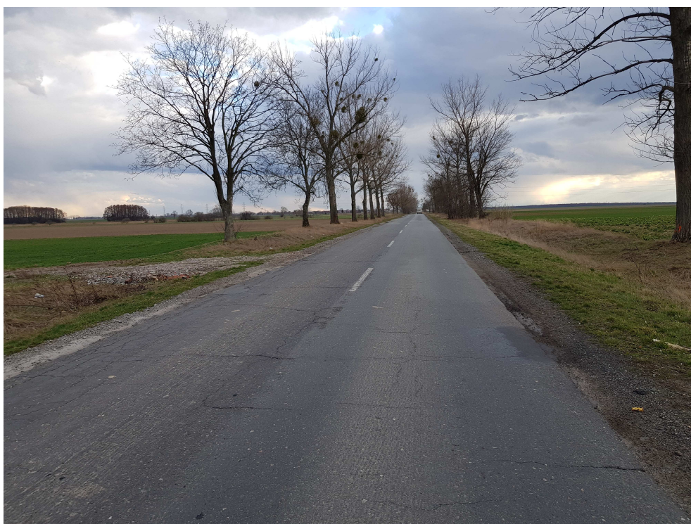
Fot. 3 Stan istniejący - km 2+300.00
