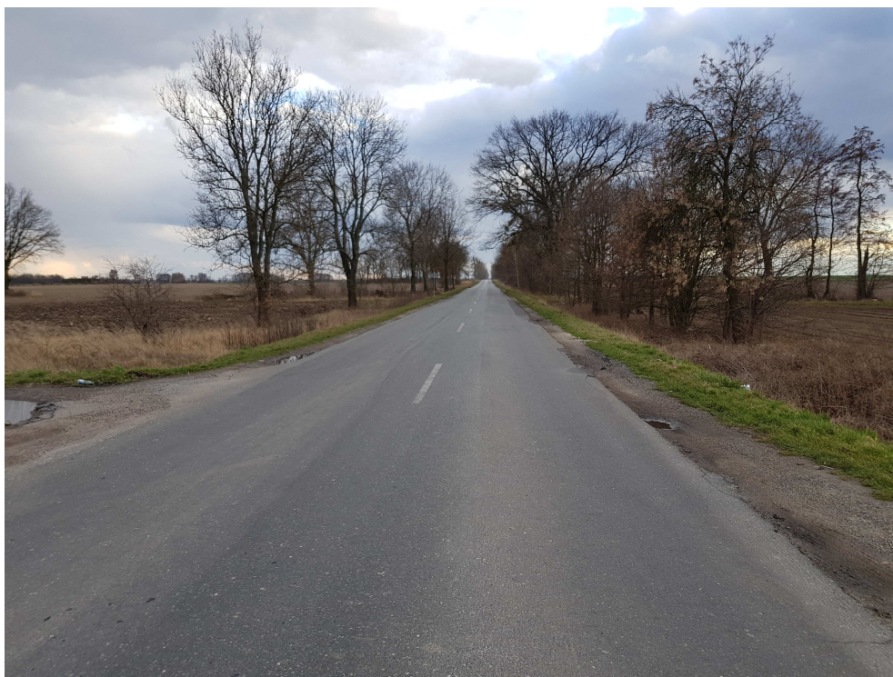
Fot. 2 Stan istniejący - km 1+350.00
