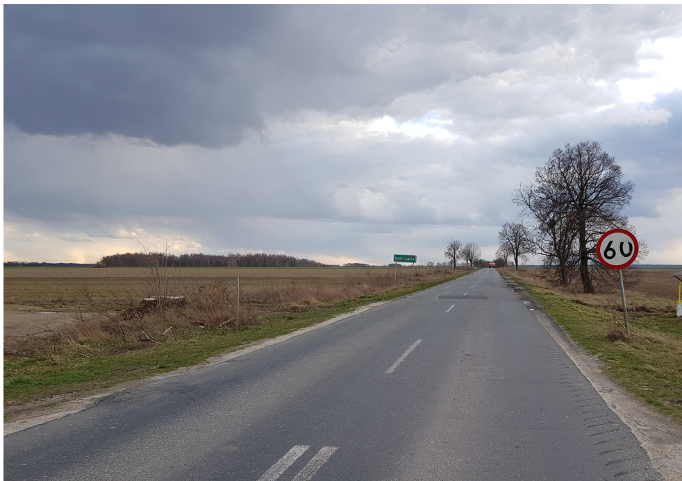
Fot. 1 Stan istniejący – km 0+200.00
